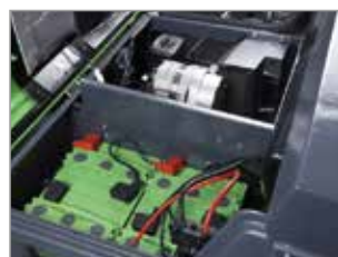
DUAL POWER CON MOTOR DIESEL
